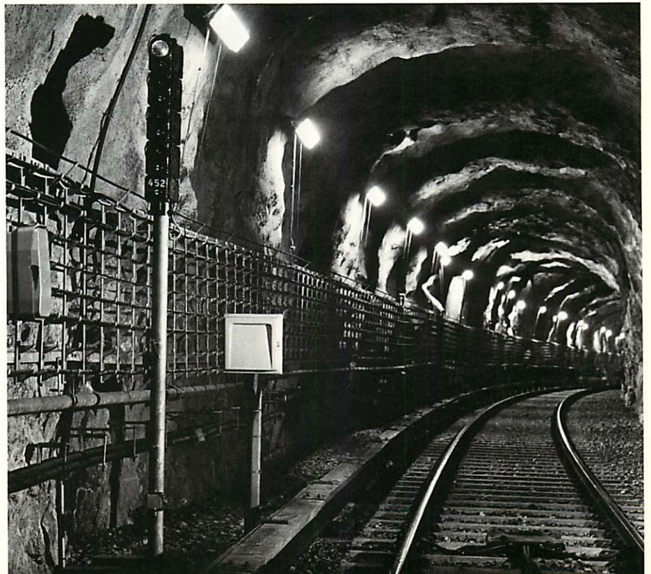
Signal i tunnel och kablar på konsoler
