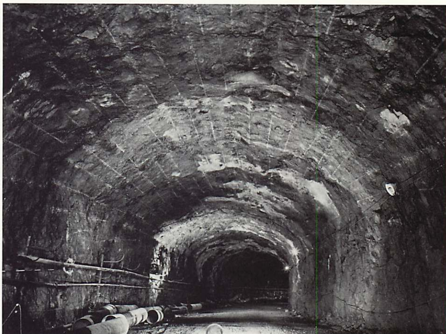
Noggrann borrhning, tät hålsättning och små laddningsmängder kan ge en jämn tunnelkontur. Dubbelspårtunnel söder om Slussen.
