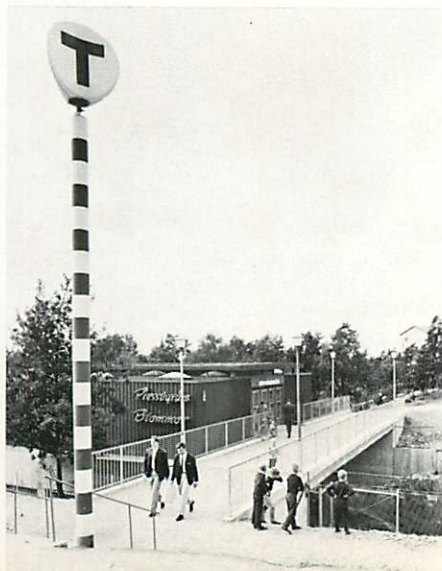
Gångviadukt vid station Hägerstensåsen
