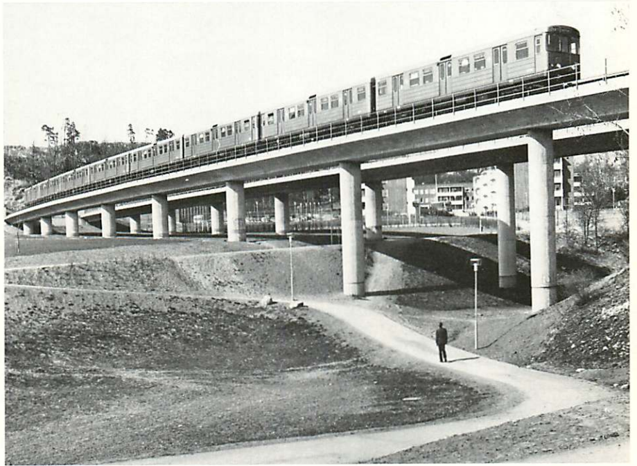
Viadukter över Vårbydalen
