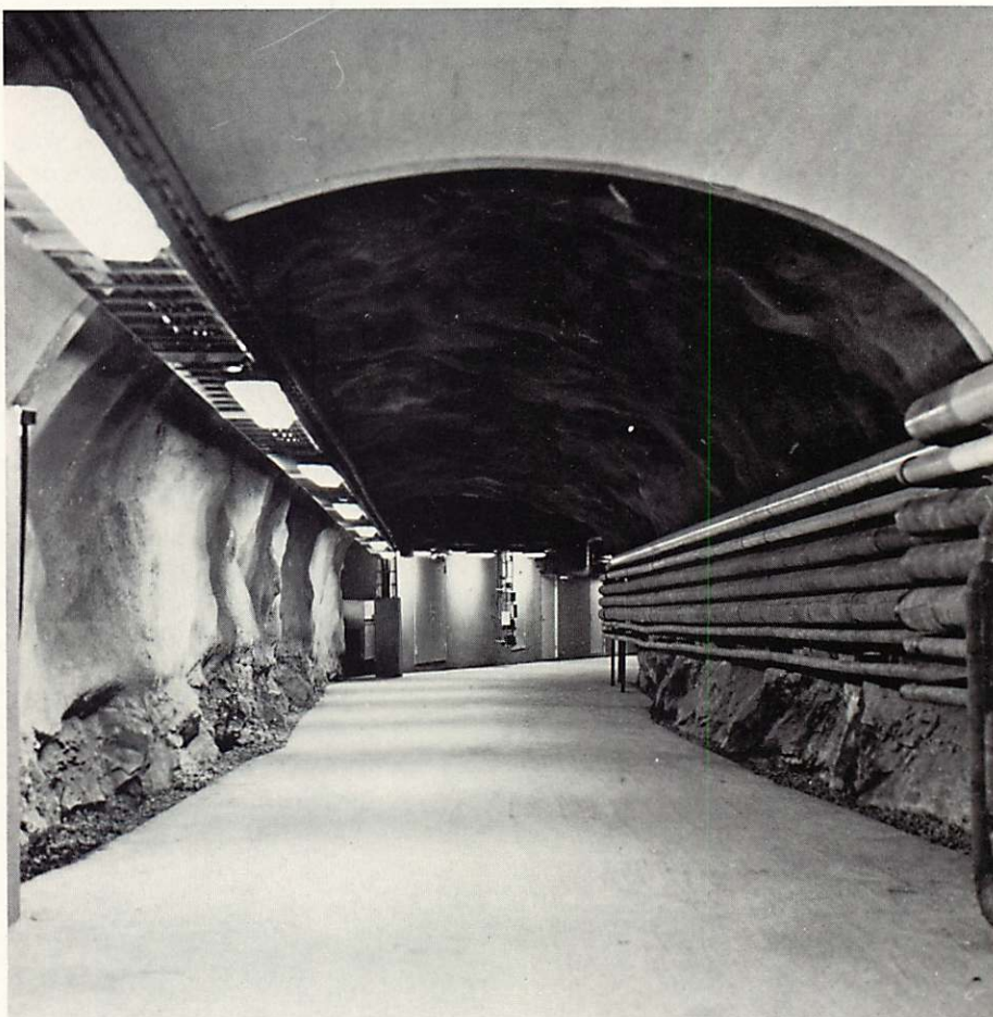
Gångtunnel vid transformatorstationen
