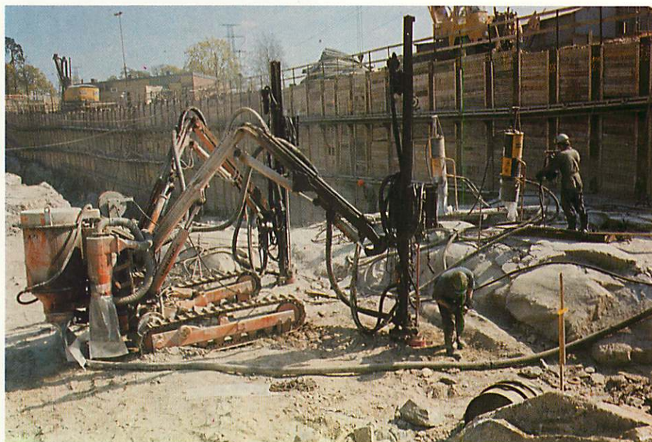
Borrning med handhållna maskiner och aggregat vid Bergshamra. Borrkaxet samlas i dammsugare.
