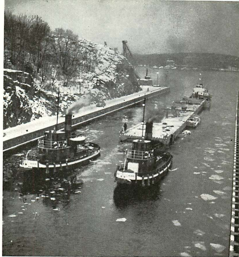
Fig. 5:25. Bogsering av betongtunnel för Liljeholmsviken.
