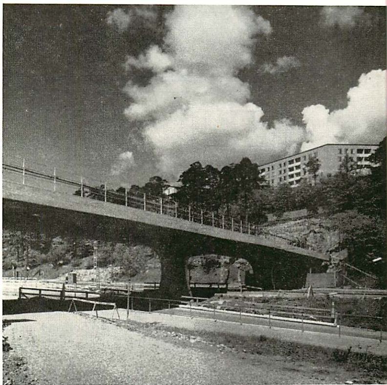
Fig. 6:10. Viadukt över Hägerstensvägen för vagnhallsspår
