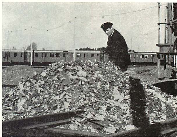
Fig. 9:10. Renhållning av spår sker med hjälp av sugtåg. Här resultatet av en dygnsrengöring.
