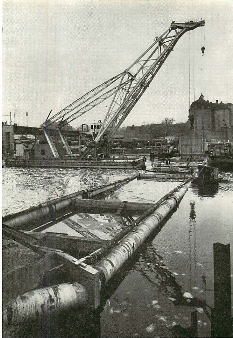
Fig. 8:13:18. För att vid sänkning av tunneln kompensera vikt förlusterna enligt Arkimedes princip lastades bl. a. betongplattor på tunneltaket.
