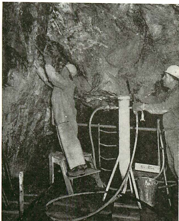
Fig. 8:2:3. Bultning för hand i borrhål fyllda till \frac{2}{3} med cementbruk.
