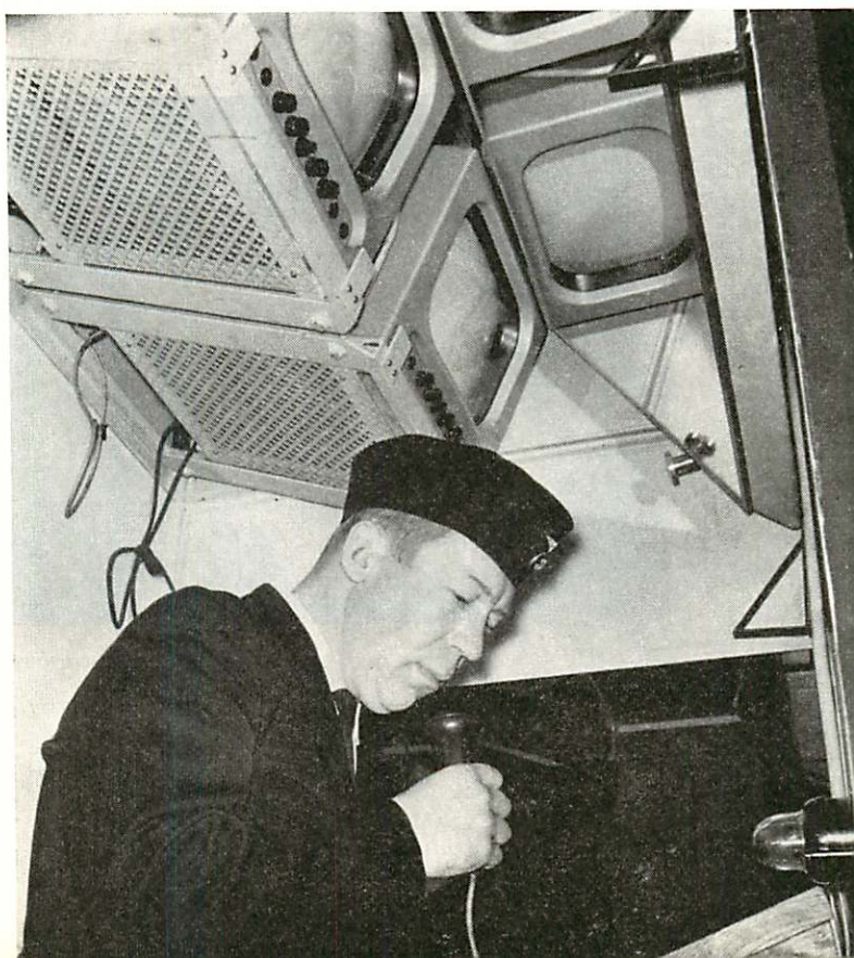
Fig. 12:1. TV-mottagare och spegelarrangemang vid station Hötorget.
