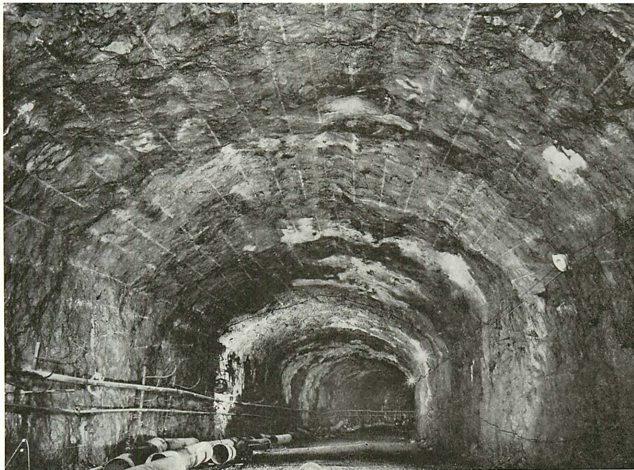
Fig. 8:1:3. Dubbelspårstunnel mellan stationerna Slussen och Mariatorget.
