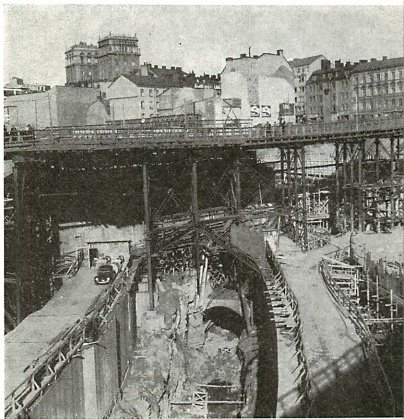
Fig. 5:16 (nedan). Tunnelarbeten vid Sergels torg.
