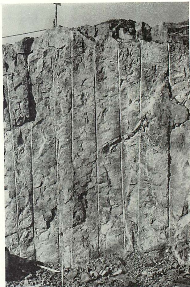
Fig. 8:1:4. Öppen bergskärning vid station Axelsberg.
