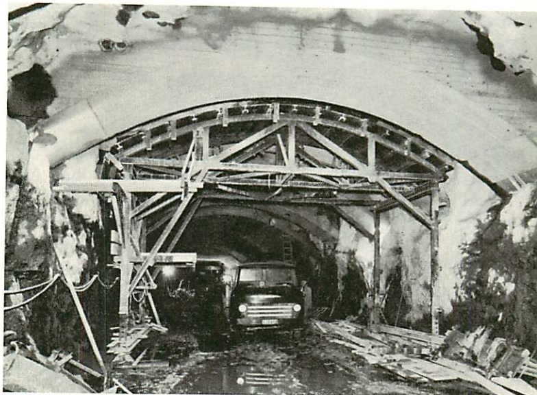
Fig. 8:6:8. Formvagnar användes även i spårtunneln på sträckan Liljeholmsviken—Liljeholmens station.
