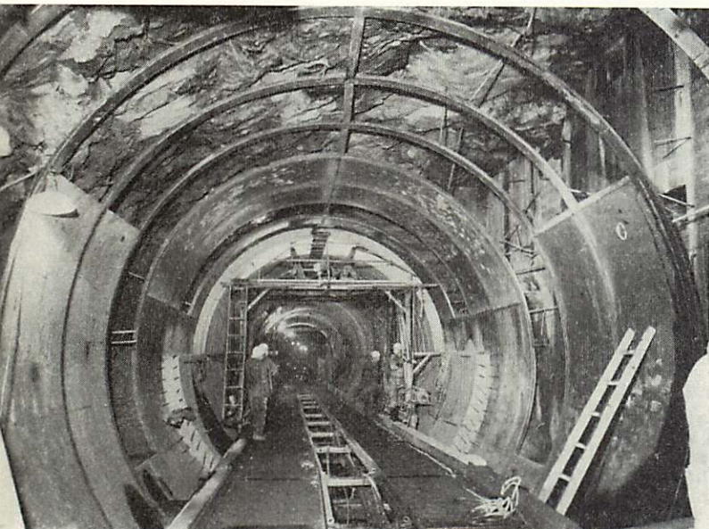
Fig. 8:15:4. Bergtunneln inklädes med plåt.
