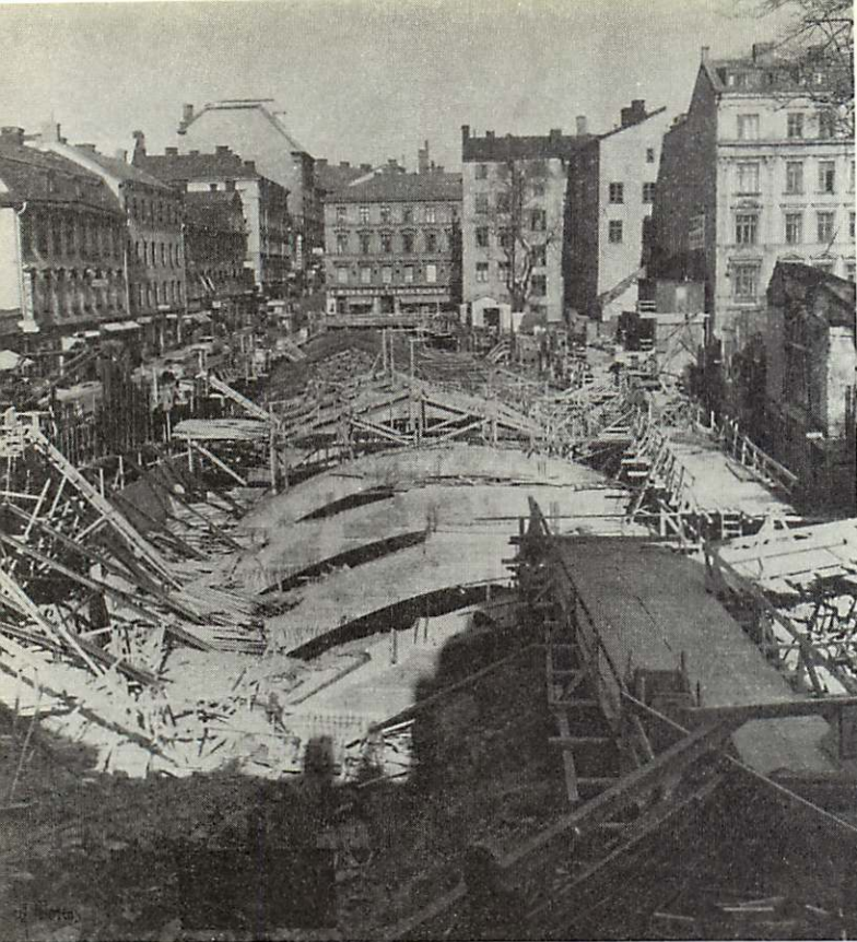
Fig. 8:10:2. De 7 betongbågarna som uppbär fastigheten i kv Orgelpipan.
