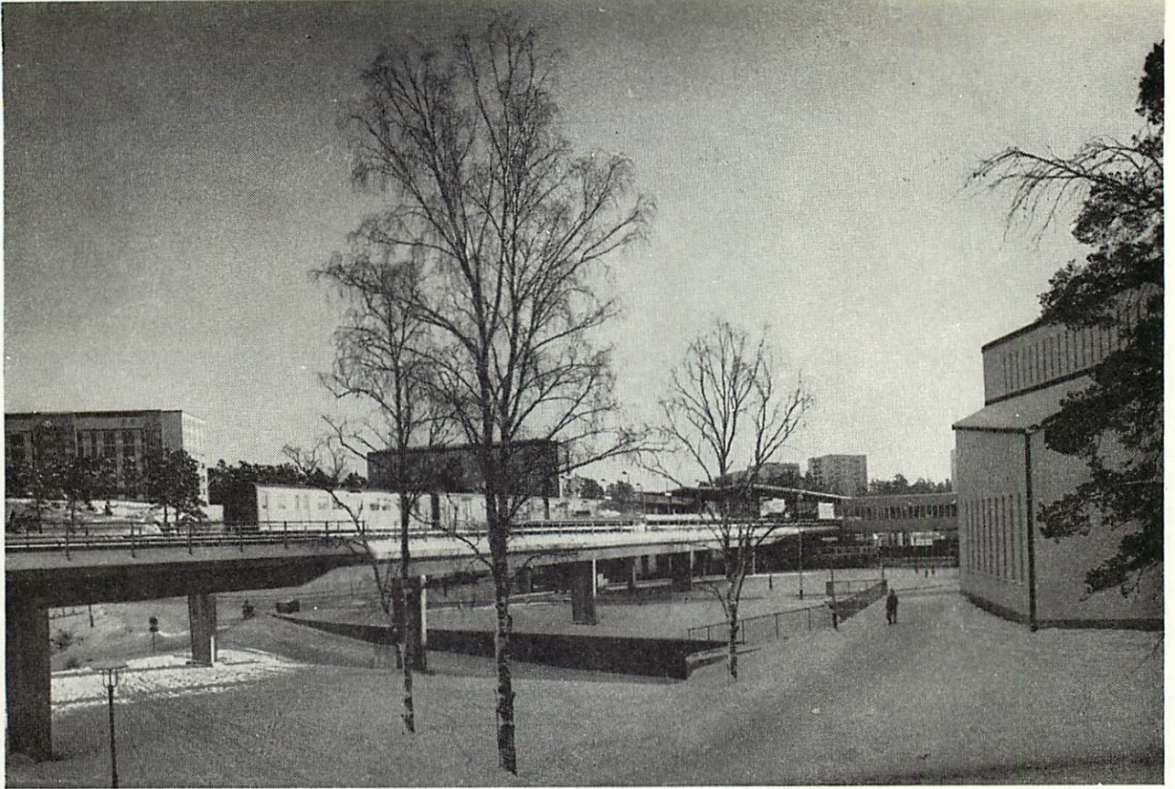
Fig. 6:3 (ovan). Viadukter vid Farsta centrum
