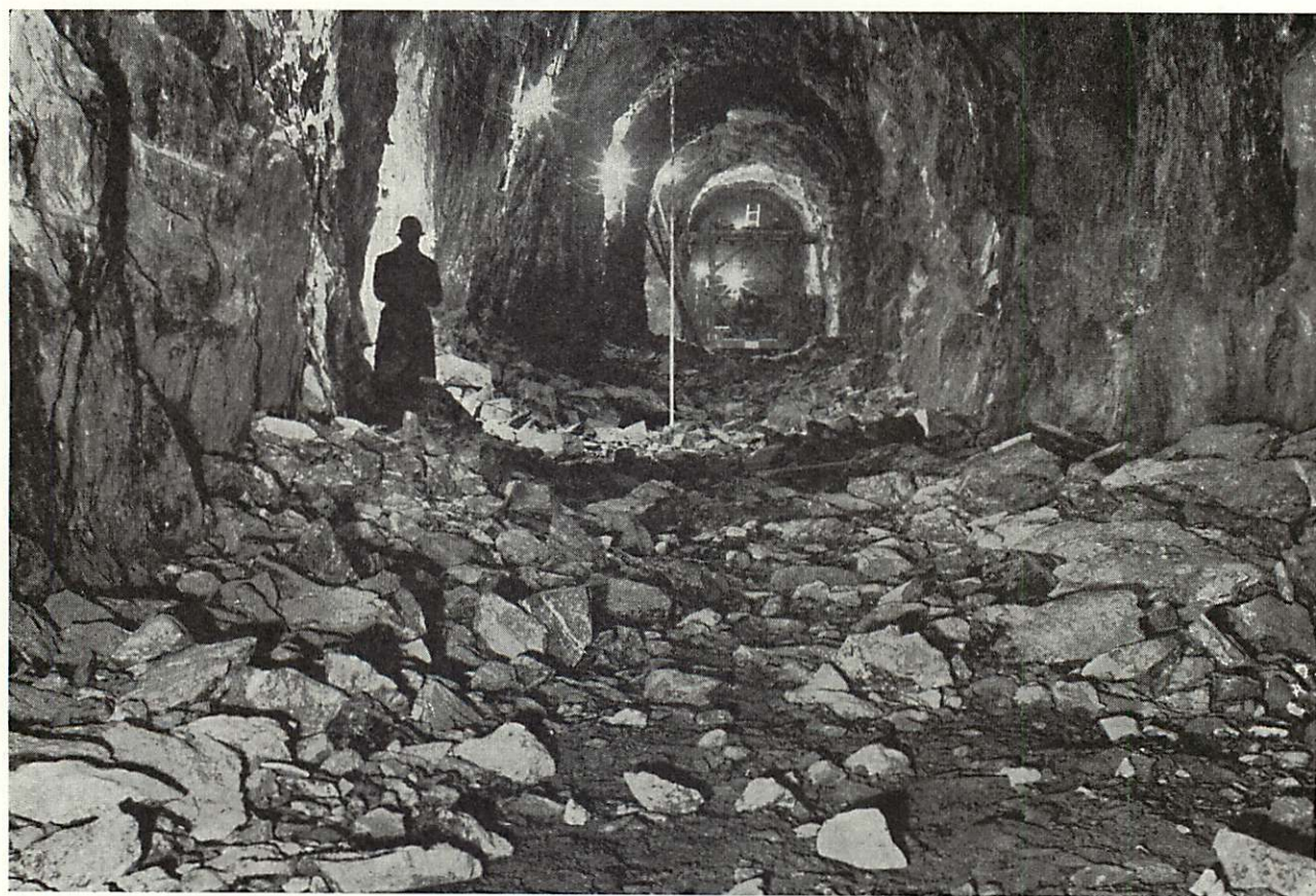
Fig. 8:2:2. Resultatet av efterskrotning i en tunnel genom gott berg där tidigare skyddsskrotning utförts.
