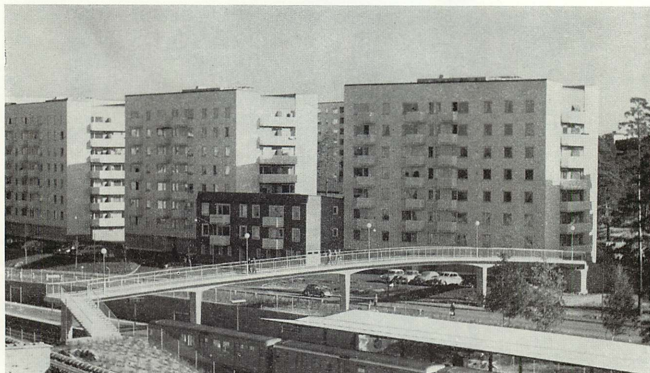
Fig. 6:9. Gångviadukt över tunnelbanan vid Hässelby Strand
