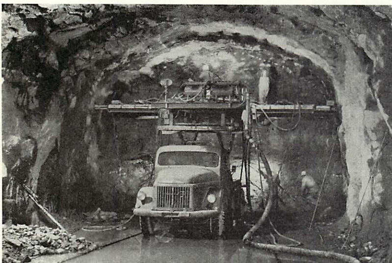
Fig. 8:1:1. Borrarbil, s. k. Svenljungatruck med hydraulisk manövrerad borrarplattform.
